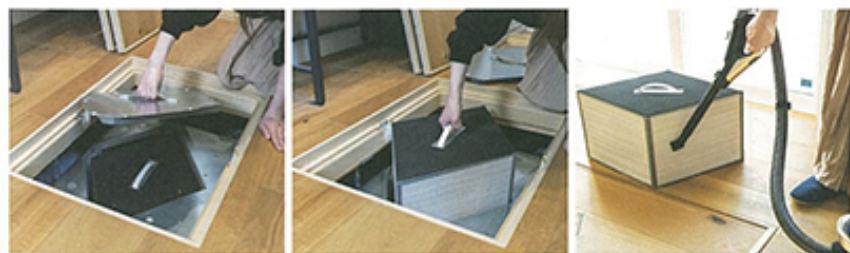
住まい手が自らマグネット式のふたを簡単に取り外して熱交換素子の掃除をすることができる
