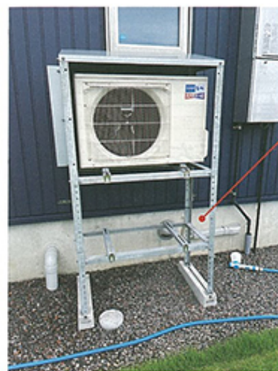
換気の排気口をエアコンの室外機の近くに設けると排気の熱で近辺の雪を溶かす効果を期待できる
