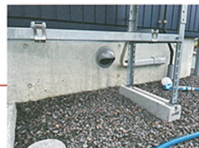
換気の排気口をエアコンの室外機の近くに設けると排気の熱で近辺の雪を溶かす効果を期待できる
