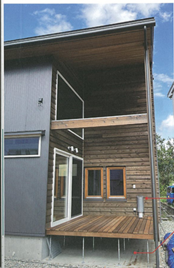
豪雪地では雪で埋まらないように屋根付きのテラスに給・排気口を設ける工夫も
