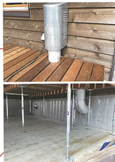
豪雪地では雪で埋まらないように屋根付きのテラスに給・排気口を設ける工夫も
