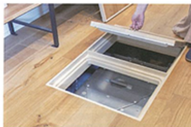
床下に熱交換器を設置する
