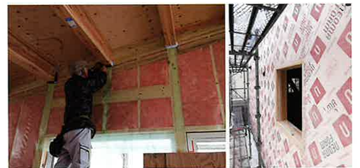
社員大工の丁寧な施工により高い断熱性能を担保する
