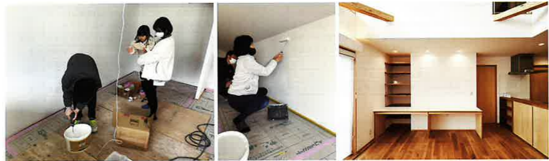
左・中:西洋漆喰をローラーで塗る施主家族。コストダウンの手法として施主によるDIYを積極的に提案 右:木と調和する美しい白さが人気の西洋漆喰。まとめて仕入れて在庫することで、少しでもコストを下げる努力をしている
