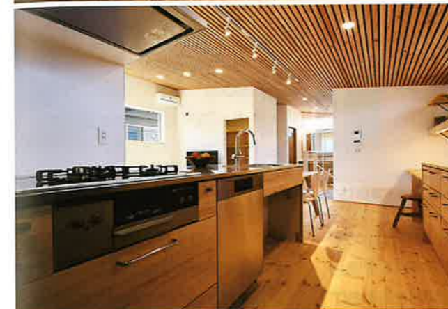
左上：下地材の野縁を張り、柿渋を塗って仕上げた天井
